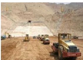
مراحل ساخت سد خاکی
